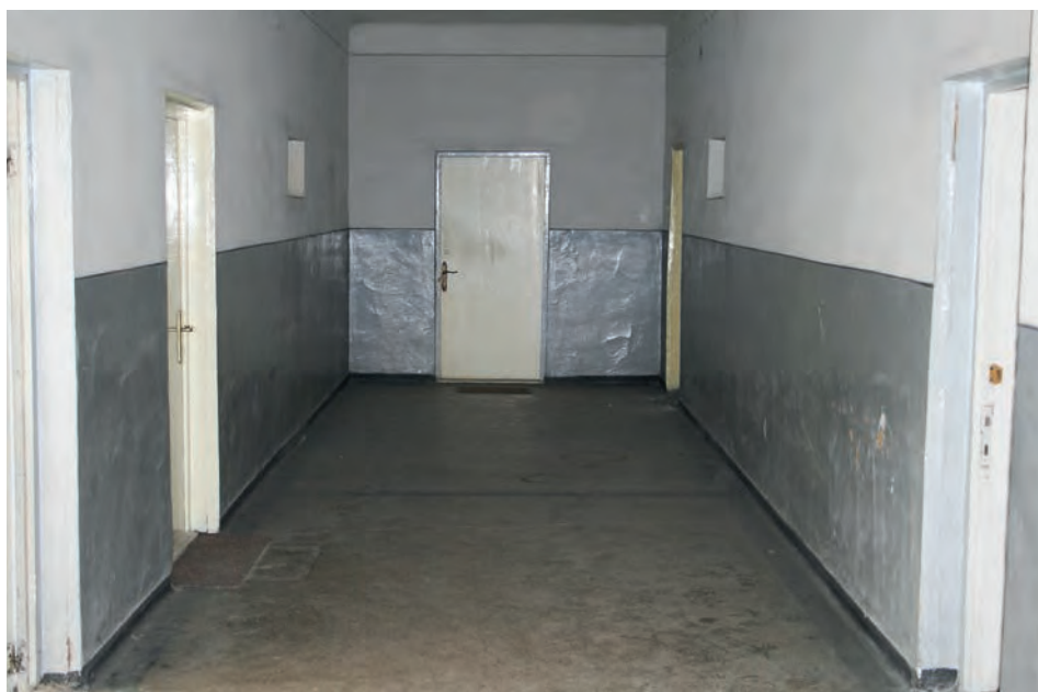
Figura 35. Culoarul spre fosta „Camera 4 Spital”.
