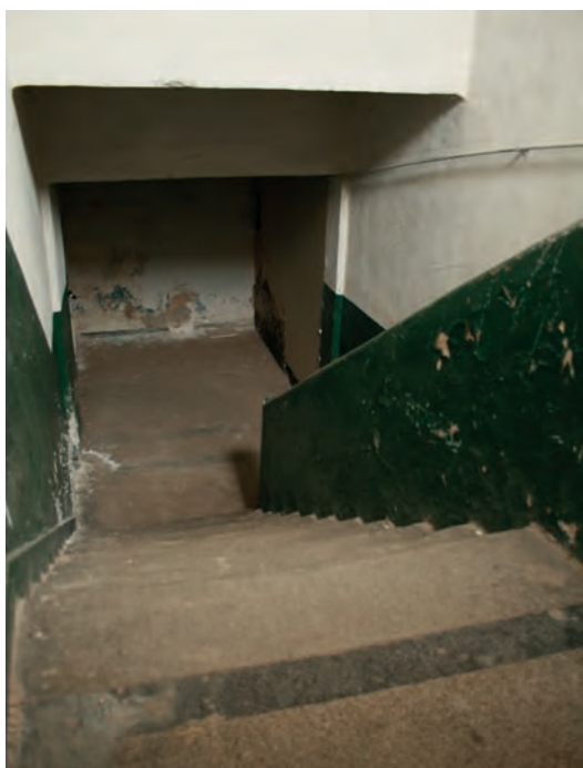
Figura 27. Scările care duc la sub-solul fostei închisori politice din Pitești; „brațul” drept al T-ului. Figure 27. Stairs leading to the basement of the former political prison in Pitești; the right side of the T.
