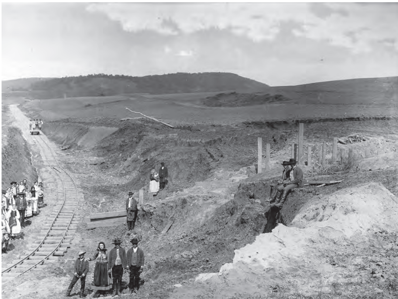
Alunecarea de teren din spatele Himberggraben (MIS).
