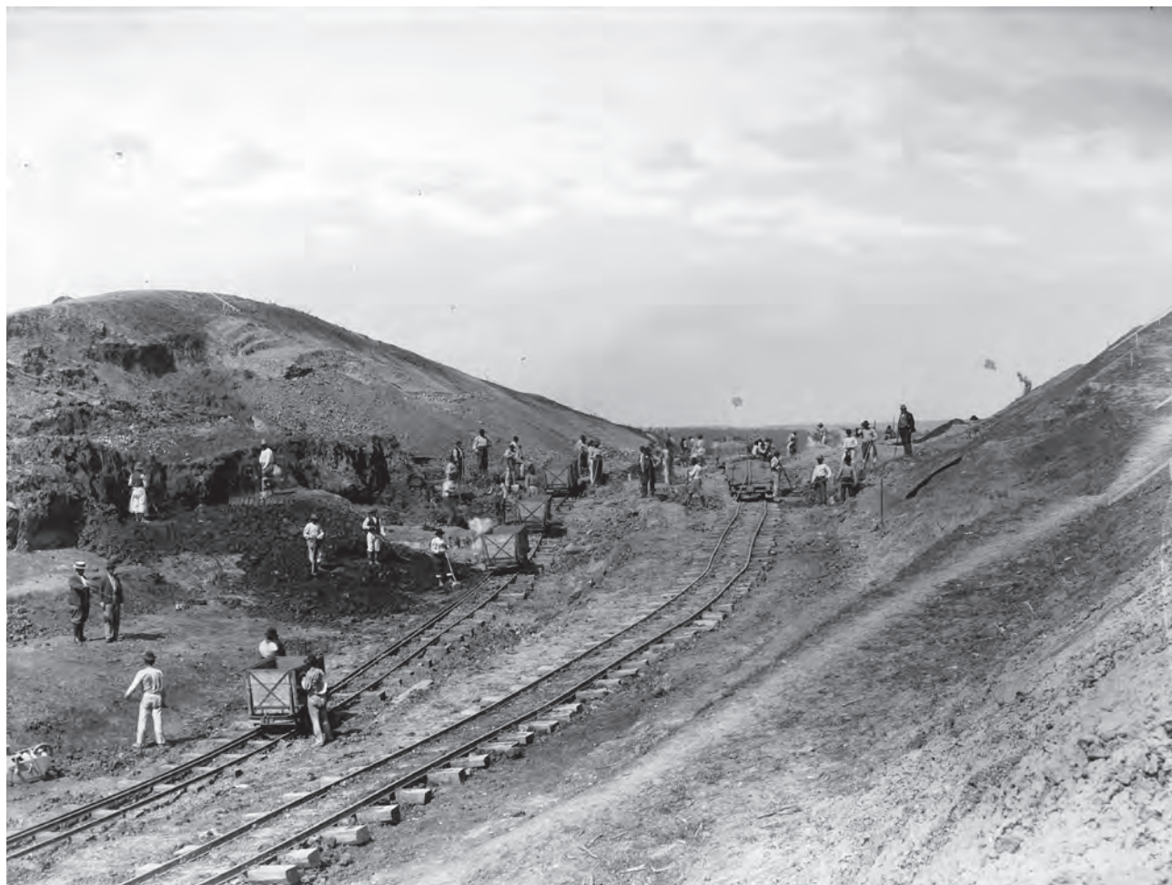
Tăietura în adâncime de 10,5 m de la cumpăna apelor dintre Apold și Brădeni (MIS).
