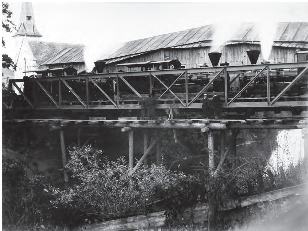
Proba de rezistență a podului din fier peste râul Târnava Mare, 20 octombrie 1896 (MIS).
